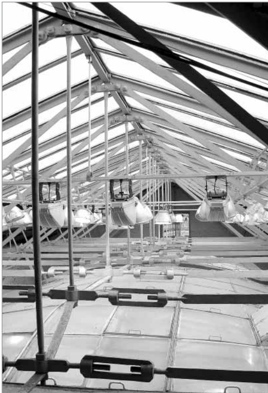
Abbildung 4: Neue Eremitage, Dachtragwerk über dem Oberlichtsaal
