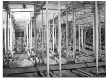
Abbildung 6: Winterpalast, Deckenträger über dem Georgievskisaal (Thronsaal), Spannweite ca. 21 m, Höhe ca. 2 m
