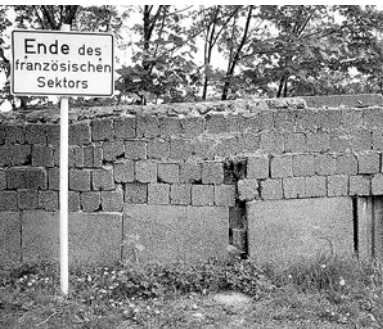
Die 1961 errichtete Mauer der 1. Generation bestand aus Blockelementen, die eigentlich für den Wohnungsbau hergestellt worden waren
