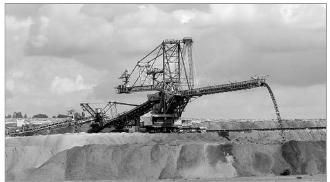
Abbildung 5: Schüttung der Deckschichten nach dem Kohleabbau im Tagebaugelände in der Niederlausitz (Foto von Oliver Dilly)
